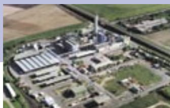
Biebesheim Sonderabfallverbrennungs- anlage, Emulsionstrenn- anlage
