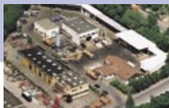
Kassel Chemisch-physikalische Behandlungsanlage, Emulsionstrennanlage, Sammelstelle
