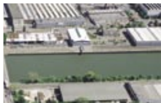
Stuttgart Chemisch-physikalische Behandlungsanlage, Sammelstelle
